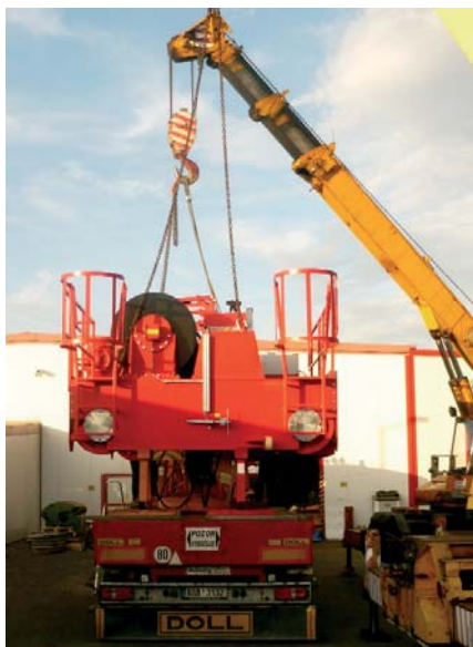
Nakládání jeřábové kočky pro přepravu do Počerad
