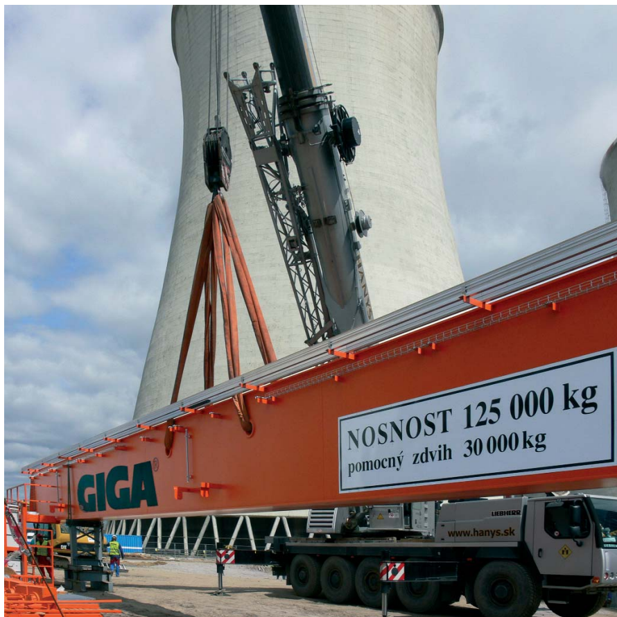
Jeřábový nosník při zdvžení na jeřábovou dráhu strojovny elektrárny Počerady
