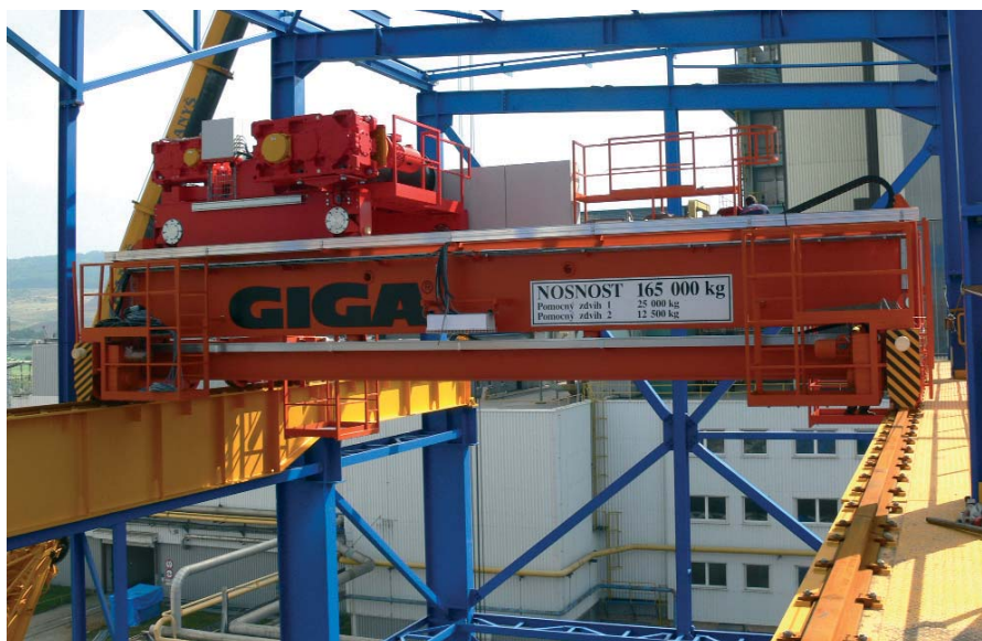
Jeřáb je usazen na jeřábové dráze a strojovna je nachystaná k instalaci opláštění a zastřešení
